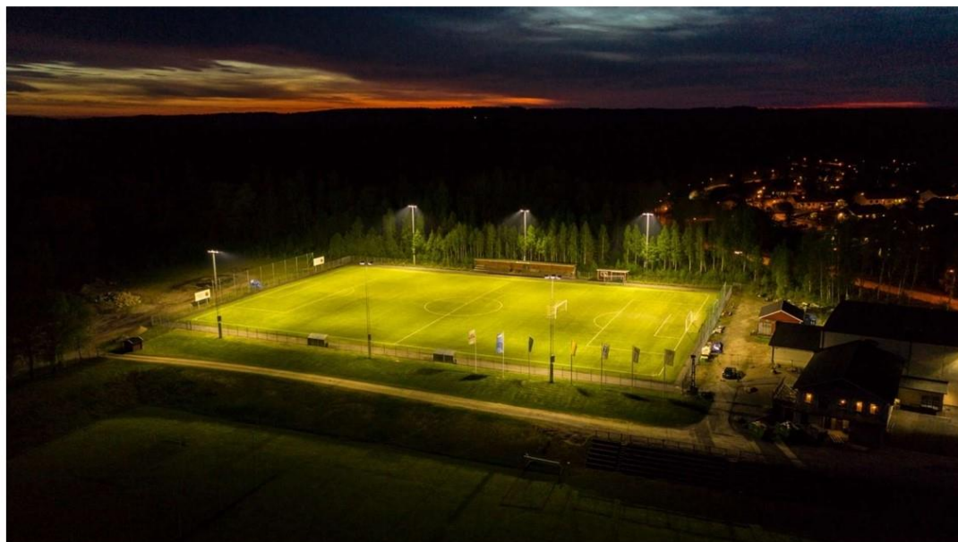
Exempel på 200 lux anläggning med 6st 18m master med flertalet asymmetriska armaturer uppvinklade 2-10grader från horisontalplan. Här ser man tydligt spilljus i trädraden men att påverkan på horisontellt ljus på marken avtar fort.
